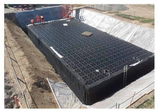
Désormais, toutes les eaux de ruissellement en amont du canal ne se déversent plus dans le canal de Versoix. Elles sont récupérées par un nouveau collecteur relié aux bassins de rétention situés sous le terrain du Verger qui est équipé d'un système de répartition à son entrée permettant le remplissage d'une cuve de 400m³. Celle-ci a été dimensionnée en fonction de l'usage du service de la Voirie.
