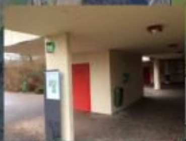
CSV, entrée vestiaires
