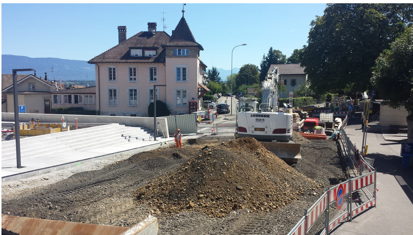
En 2015, plusieurs chantiers sont en cours, également à Versoix Centre-Ville
