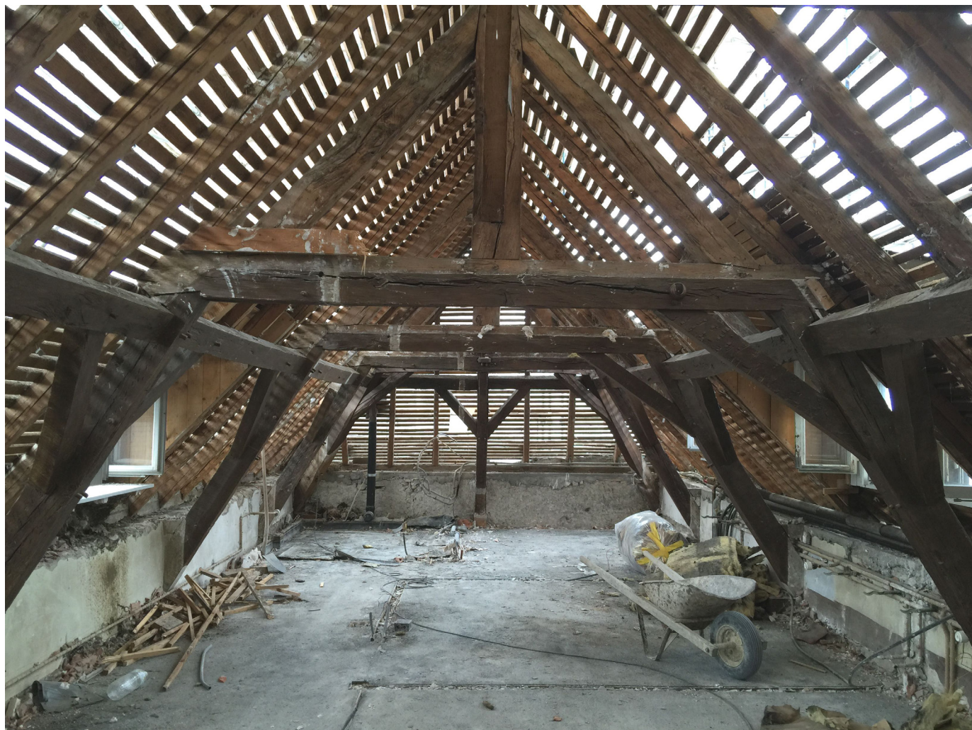
Les combles du Château d'Ecogia au moment des travaux
