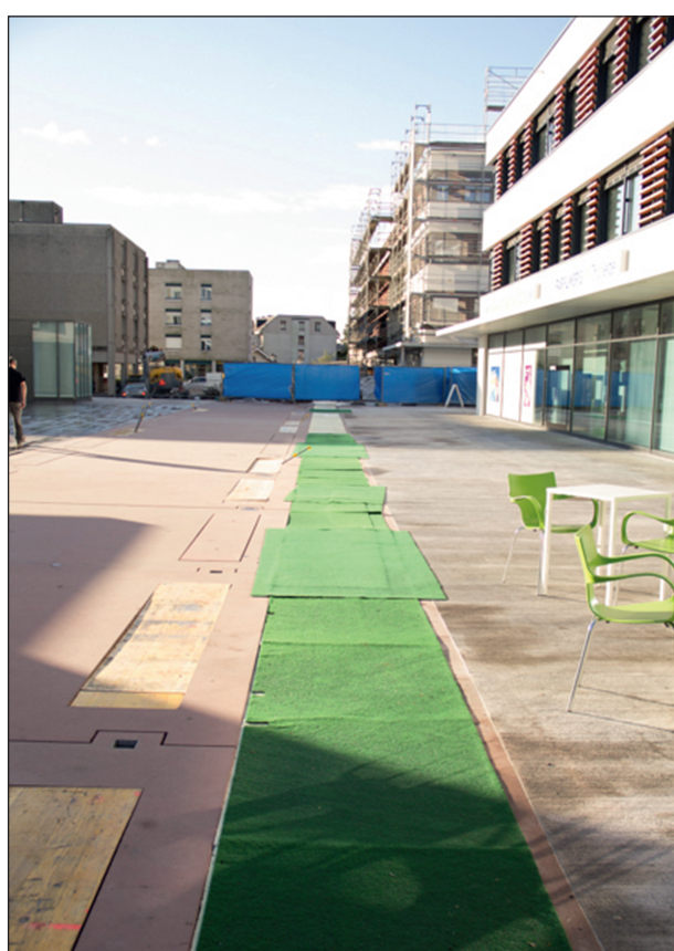
Versoix Centre-ville prend forme avec de haut en bas la terrasse de l'hôtel sur l'esplanade, un bâtiment commercial et, sous un tapis de protection, le futur canal qui traversera le quartier.
