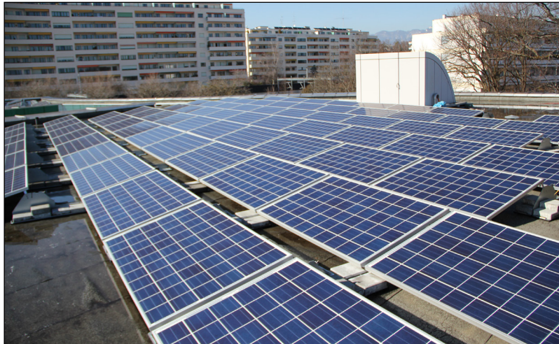
Vue de la toiture.
