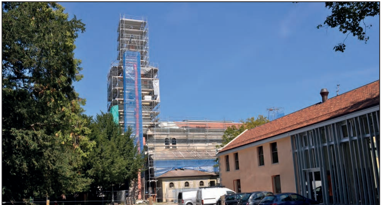
Travaux de réfection du clocher et des façades de l'Eglise.
