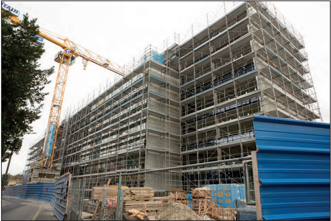
Vue direction Genève de l'immeuble en construction.
