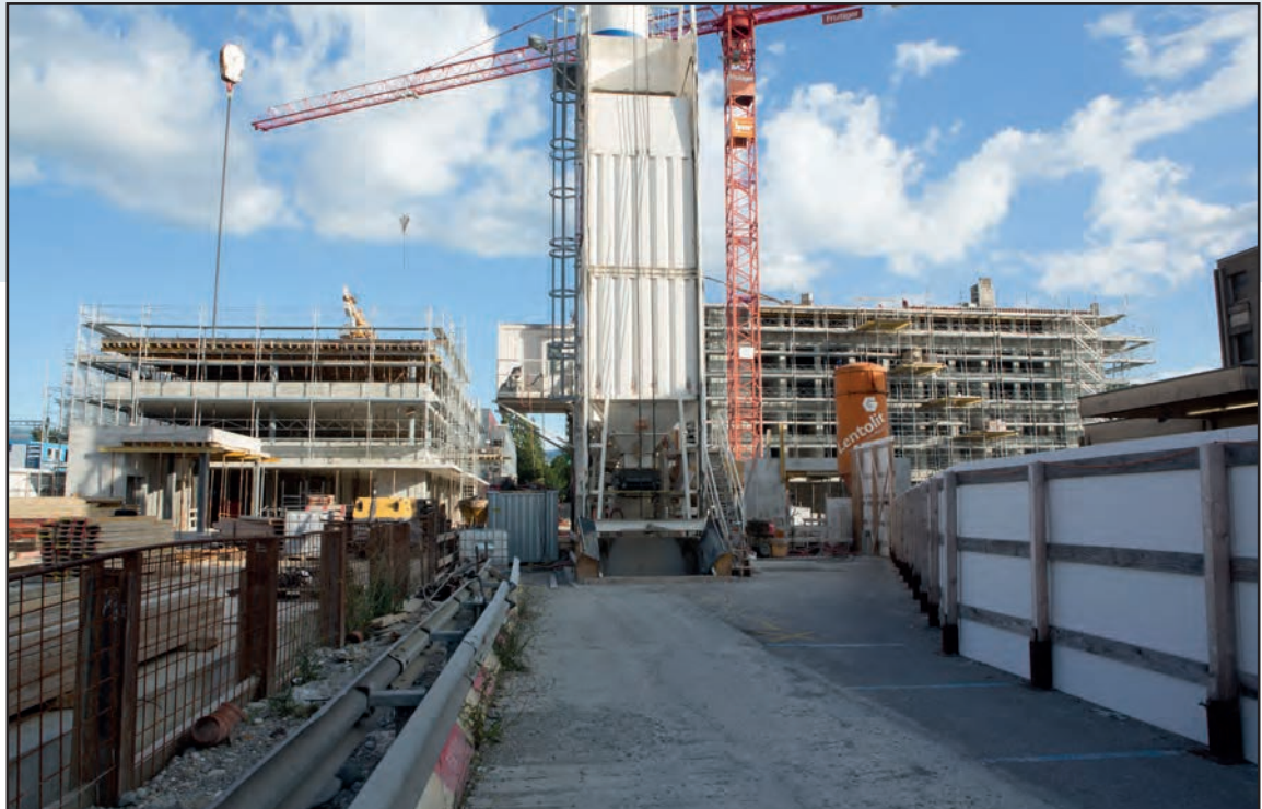
Photo prise depuis la rampe d'accès provisoire au chantier. Avec, à gauche, l'immeuble B (n°4 sur le plan) et à droite le futur hôtel (n°2 sur le plan).
