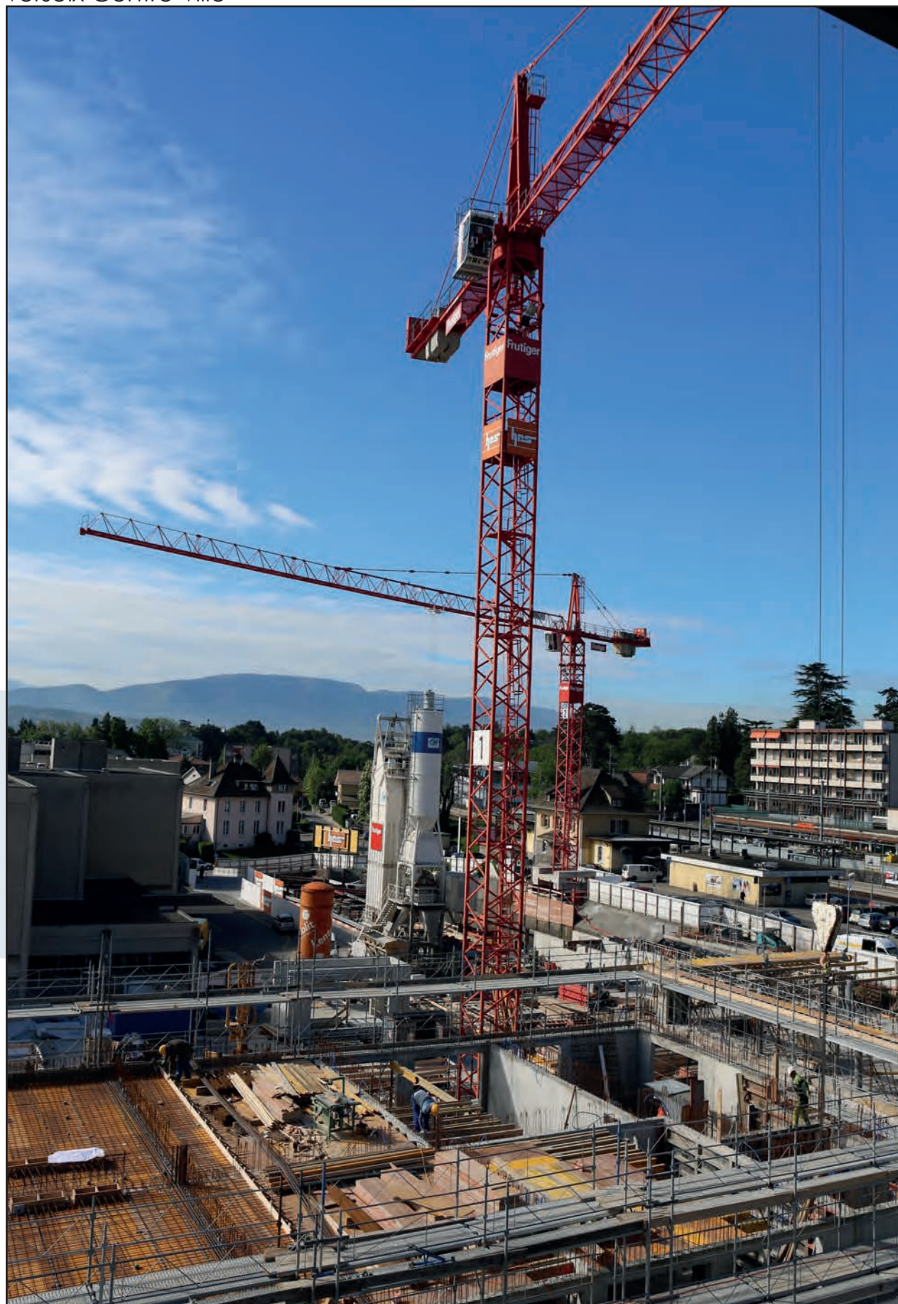
Vue d'ensemble au premier plan du terrassement et de la construction des sous-sol de l'hôtel (n°2 sur le plan).
