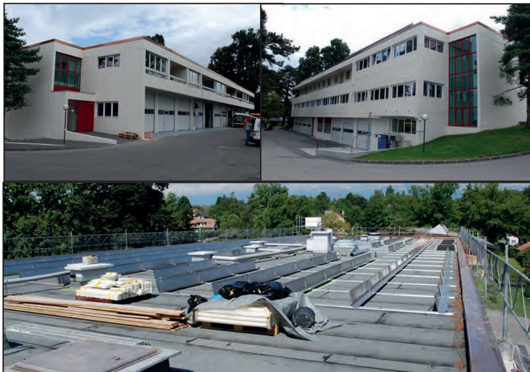
Les nouvelles façades du bâtiment de la Voirie et la mise en places des panneaux solaires.
