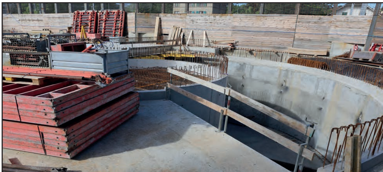
Rampe d'accès au parking du futur immeuble.
