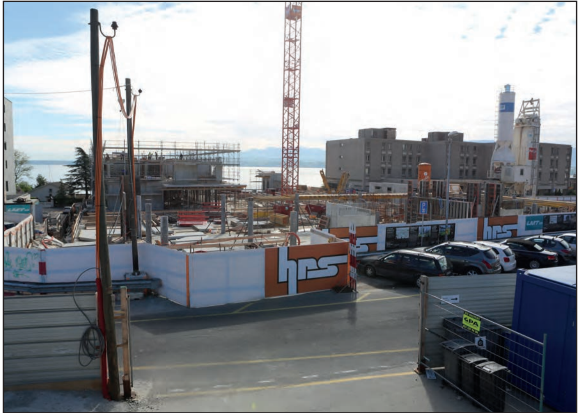
Vue du chantier depuis le chemin Vandelle.
