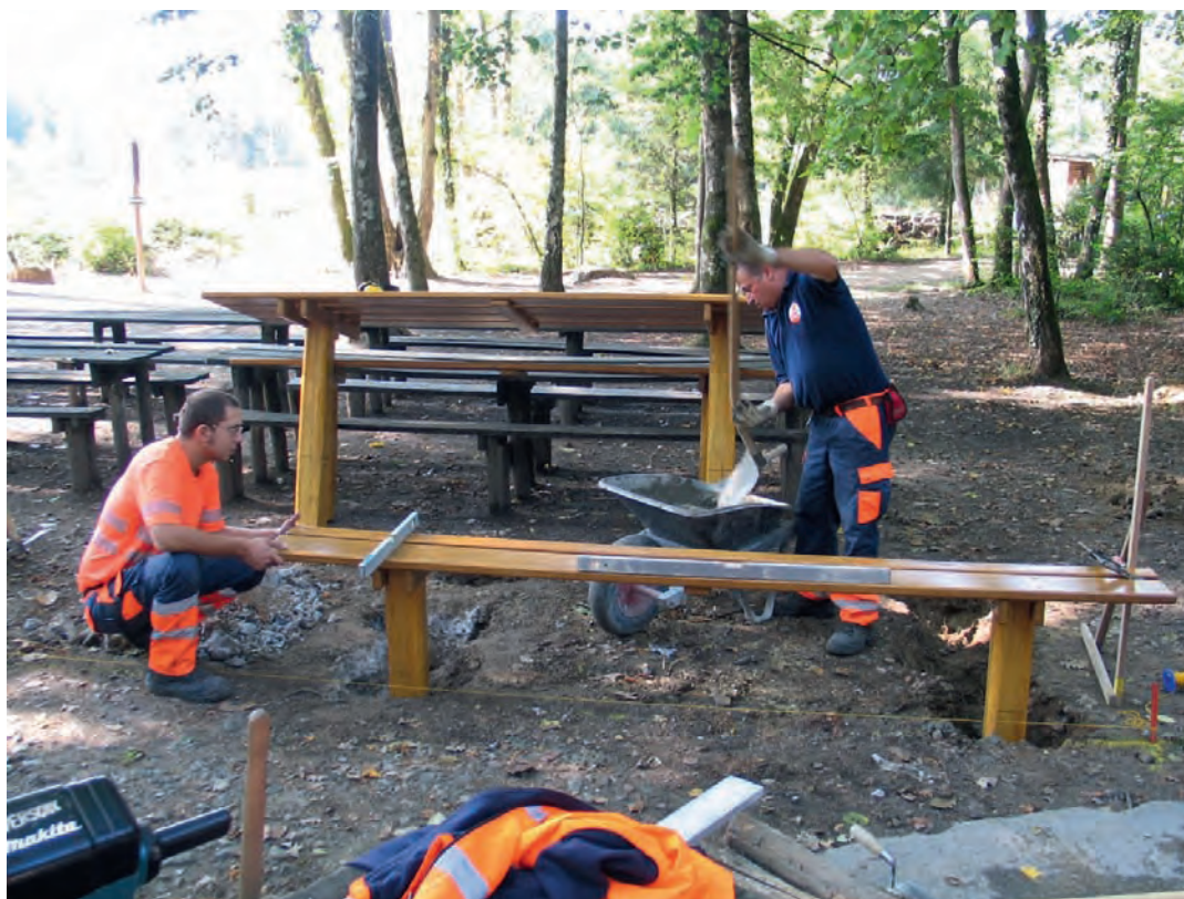
Pose d'une nouvelle table à la cabane des Bûcherons
