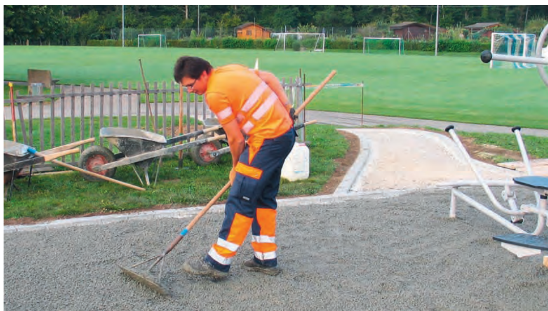
CSV : pose de béton caverneux pour l'espace fitness plein air. 15.9.2011
