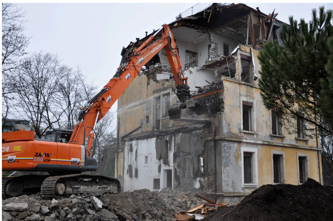
Mars 2009, îlot nord de Versoix Centre-Ville: démolition de la Maison Giroud
