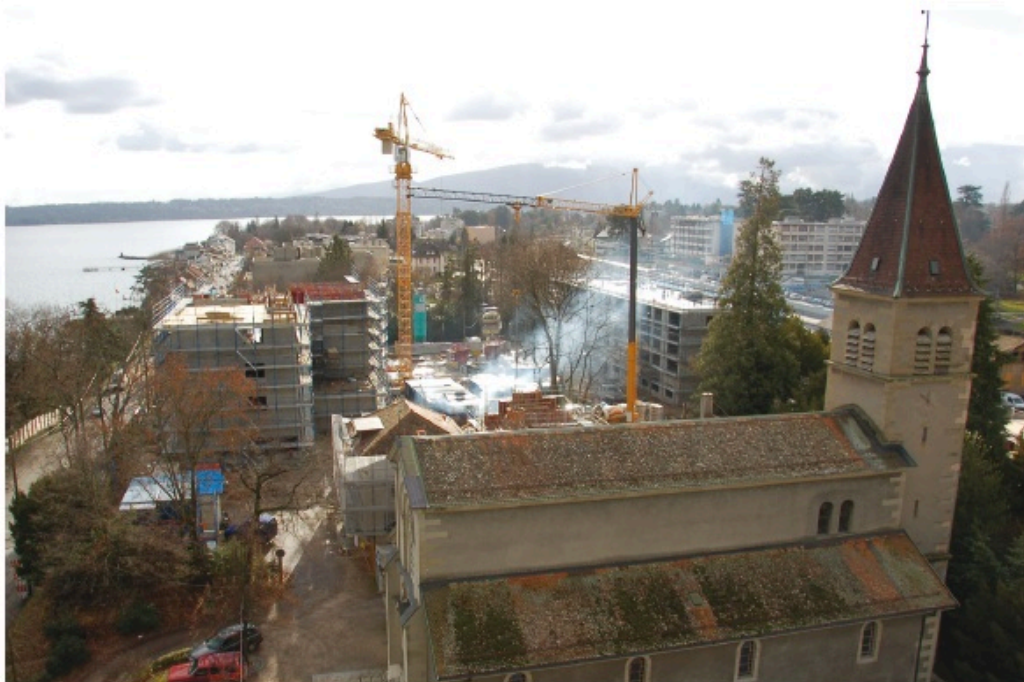
Versoix Centre-Ville, îlot nord, le 4 décembre 2009
