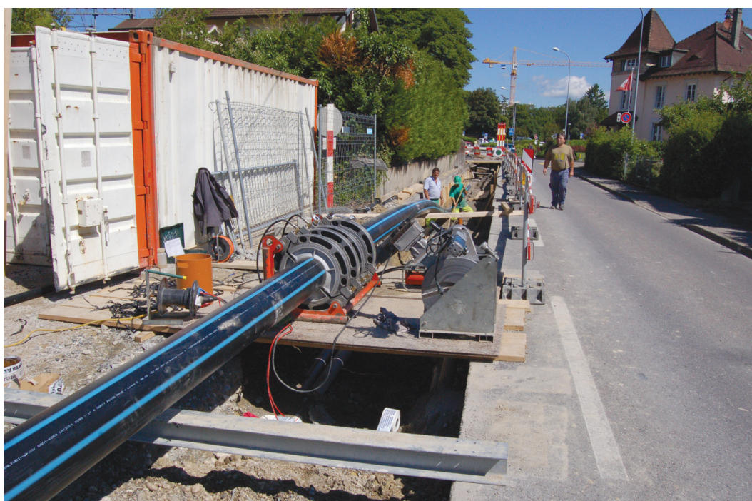
Pose de la conduite d'eau pour le chauffage à distance. En direction de Versoix Centre-Ville
