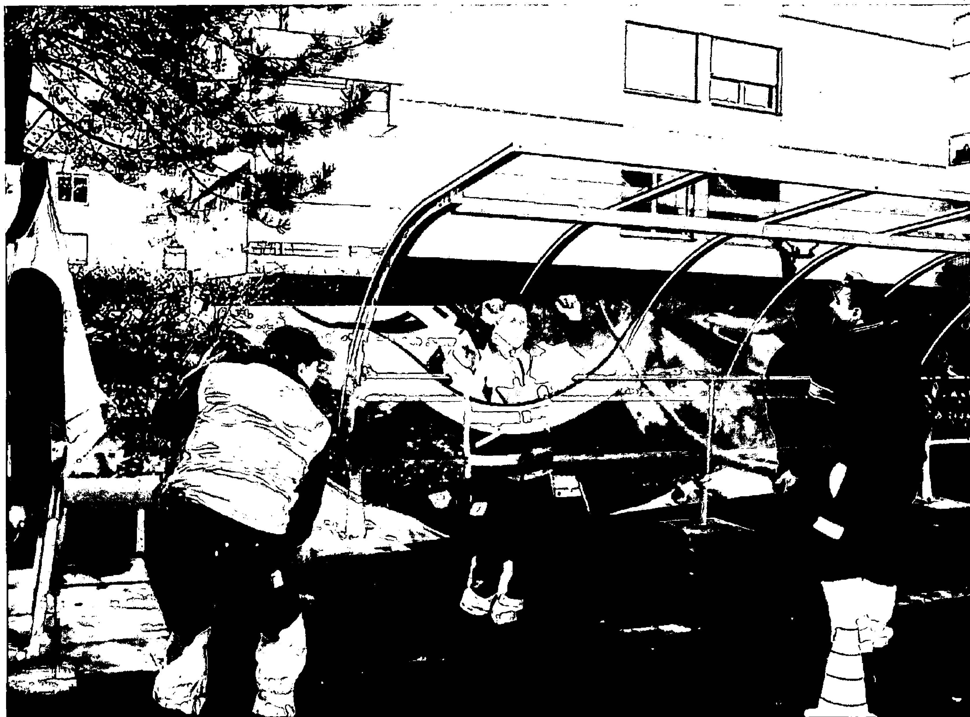
Mise en place abri vélos chemin de Pont-Céard par la Voirie
