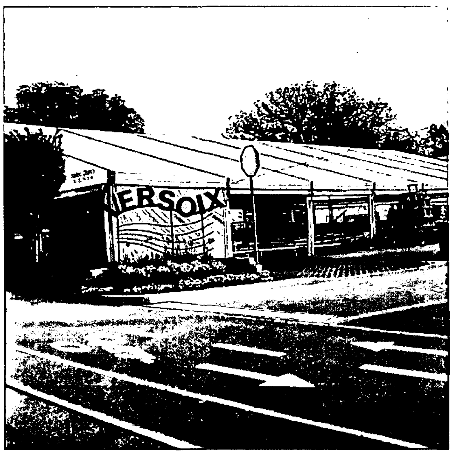
FÉDÉ 2005 sur le «Verger» du Centre Voirie
