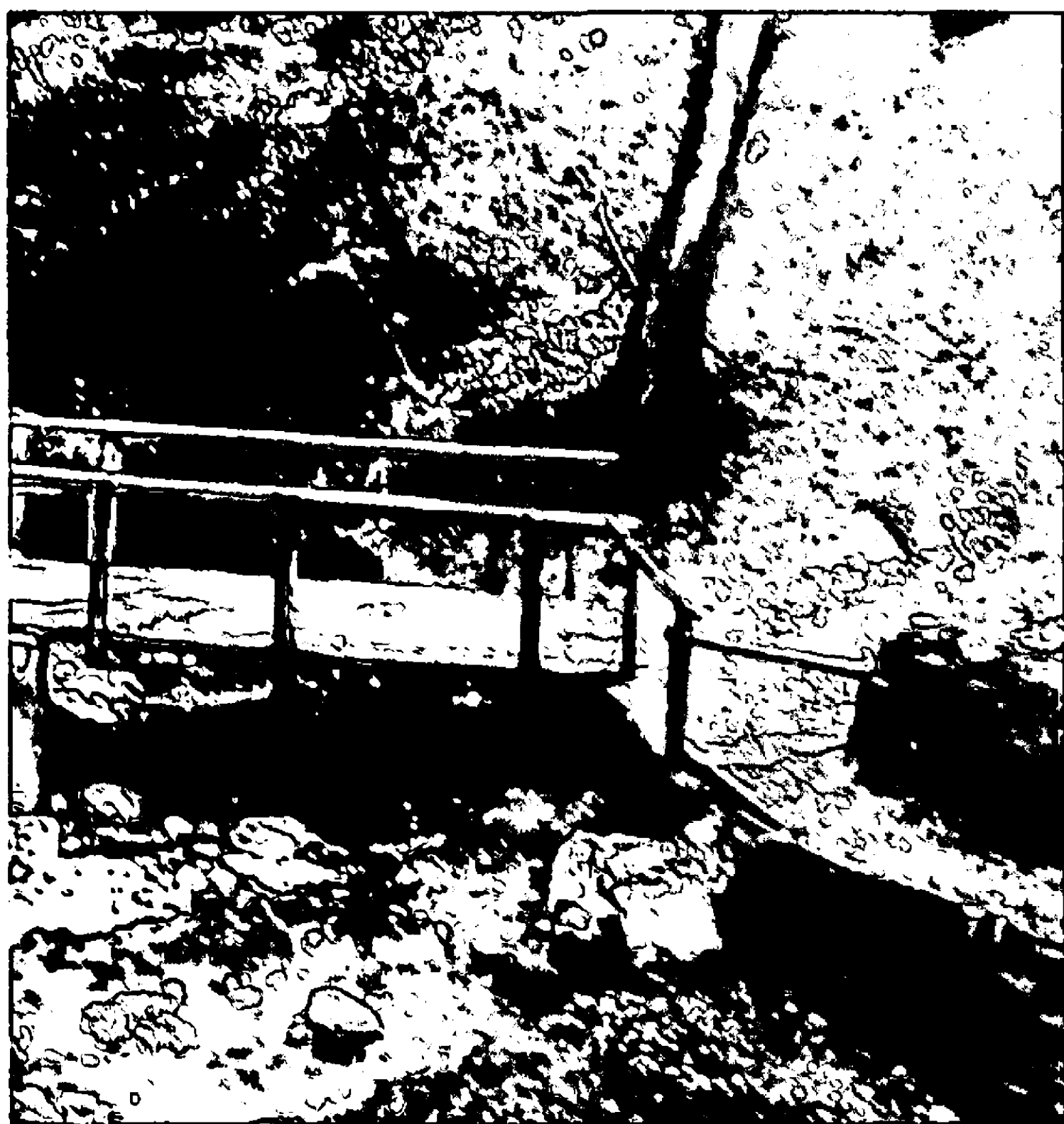
Nouvelle passerelle enjambant le Nant de Braille en contrebas des immeubles du Grand- Montfleury
